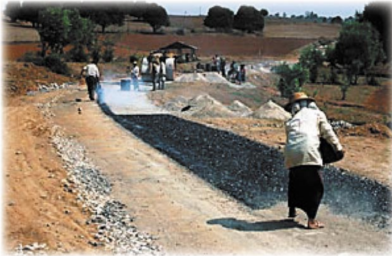
Straßenbau bei Pindaya
