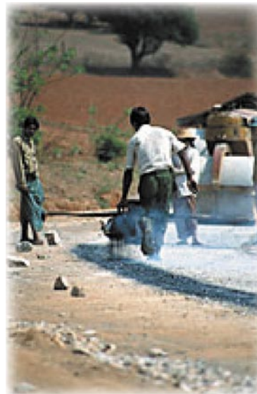
Straßenbau bei Pindaya
