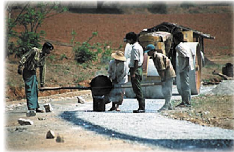
Straßenbau bei Pindaya
