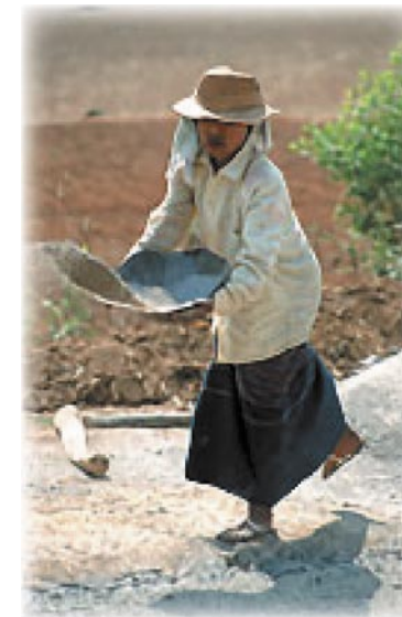
Straßenbau bei Pindaya
