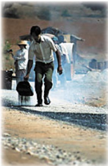
Straßenbau bei Pindaya
