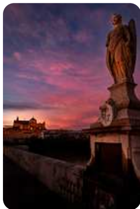
Puente Romano de Cordoba
