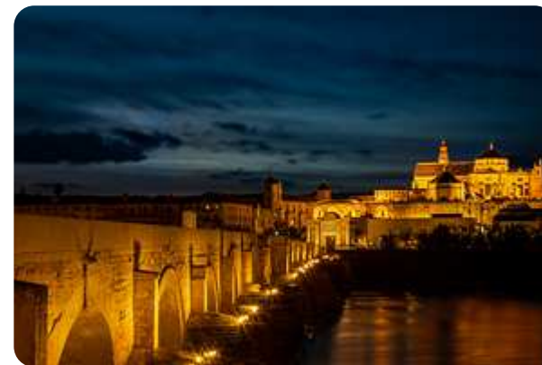
Puente Romano de Cordoba
