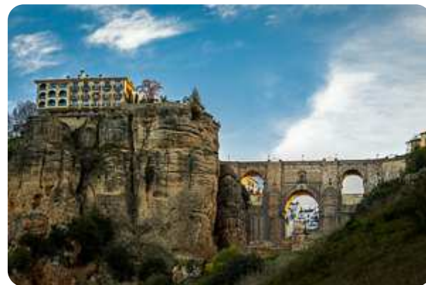
Puente Nuevo - Ronda
